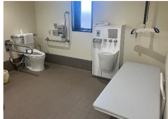
＜多目的トイレ＞ 天井走行リフター、折畳み寝台、オストメイト対応トイレを完備しています。
